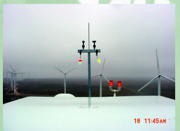
FireFly bakenkaarten boven op windmolens (New Mexico, USA)
